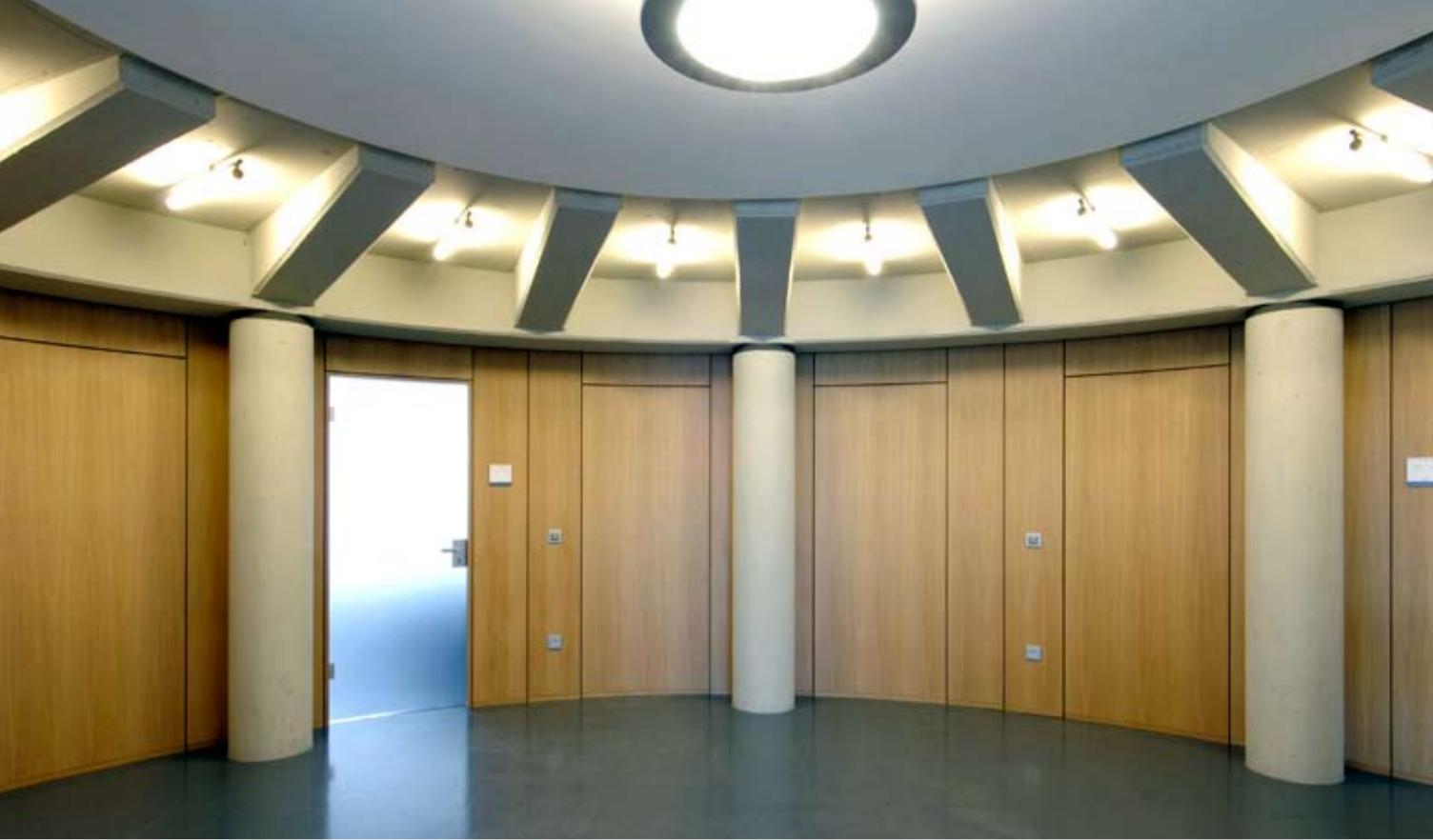
Objekt mit runden Trennwänden/Türen, formverleimt mit Geistlich-Placol 4507 + Härter 20V2 Presszeit bei 20°C 30-40 Min. - Duroplastische Harnstoffharzverleimung
