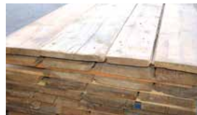
Pavimento legno vecchio calpestato
